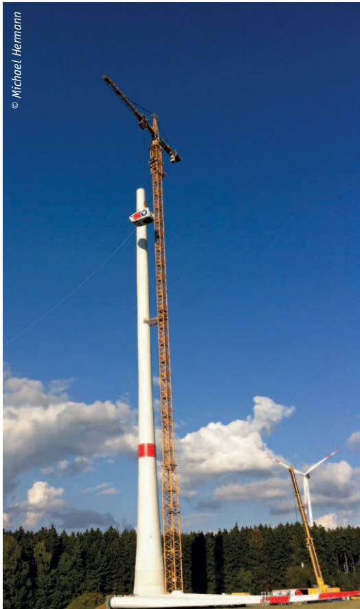
Errichtung der Windenergieanlage Stemmasgrün/ Fichtelgebirge
